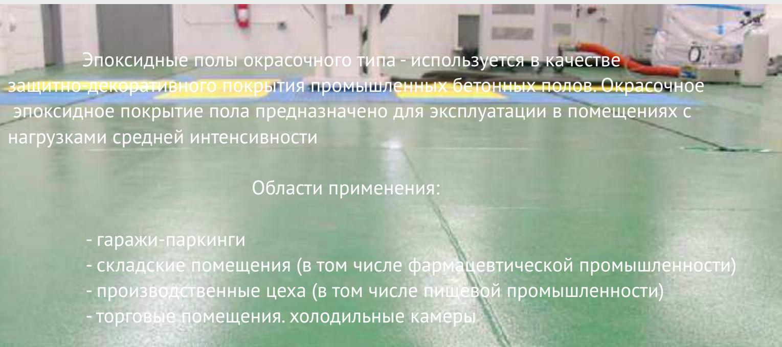
Эпоксидные полы окрасочного типа - используется в качестве защитно-декоративного покрытия промышленных бетонных полов. Окрасочное эпоксидное покрытие пола предназначено для эксплуатации в помещениях с нагрузками средней интенсивности
